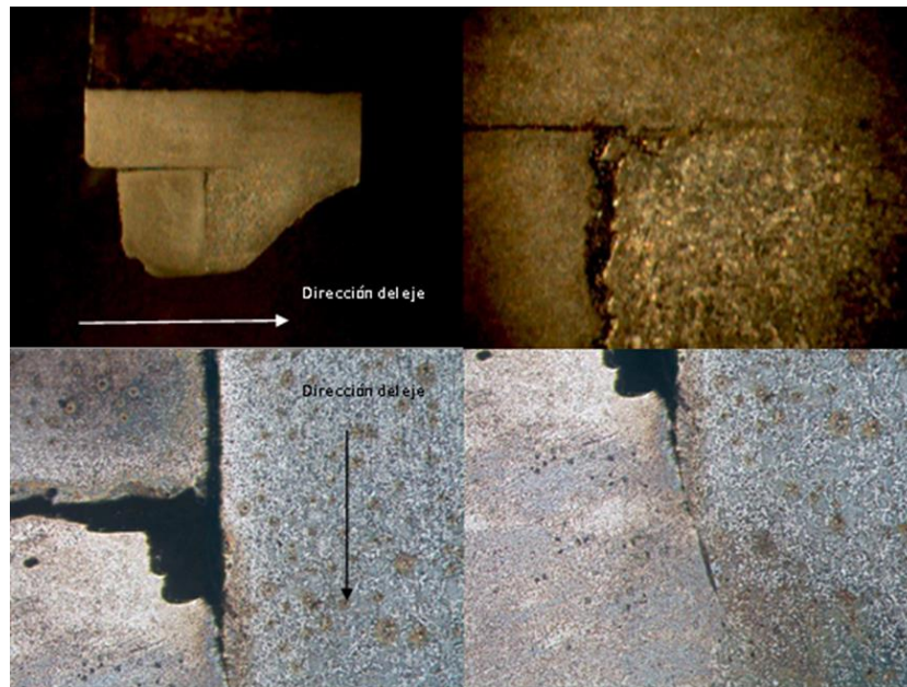
Figura 9. Detalle de los defectos en la soldadura. Fuente: informe de Laboratorio JST
