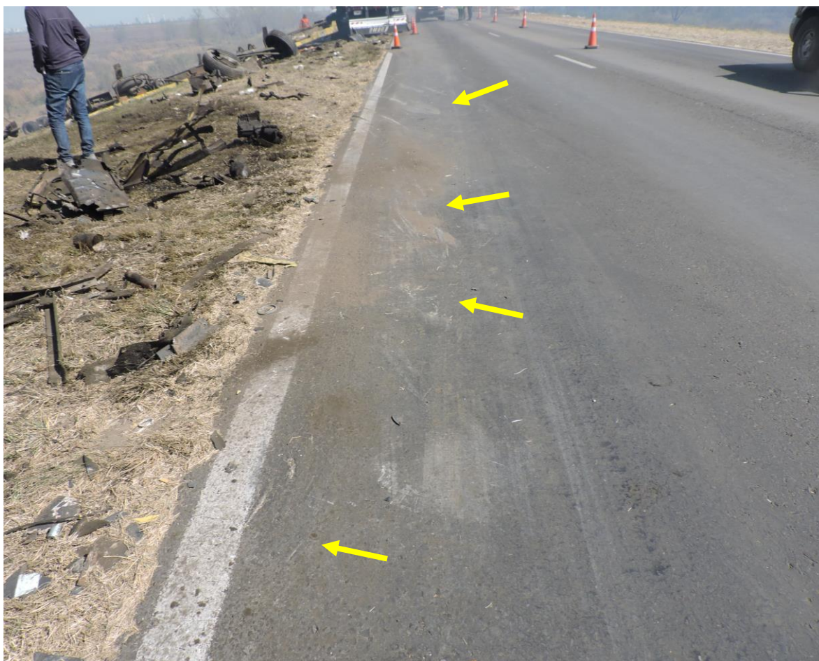
Figura 9. Huellas de efracción sobre la calzada. Fuente: JST, 2022
