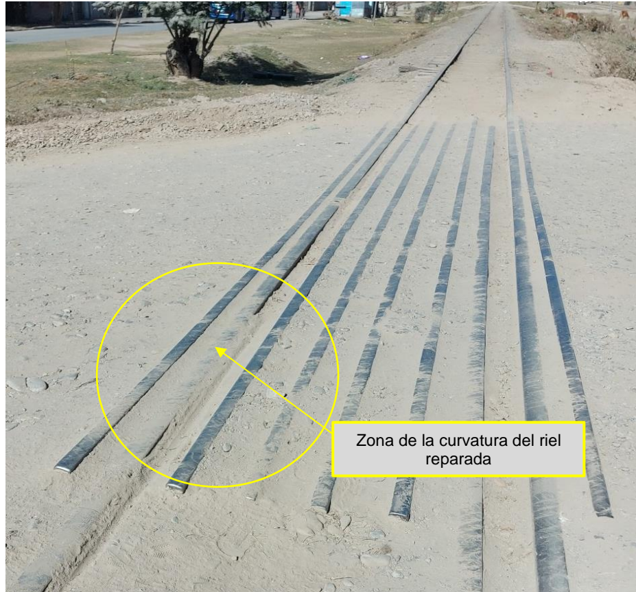
Figura 18. Vía férrea reparada (imagen de un año después del accidente). Fuente: JST, 2022
