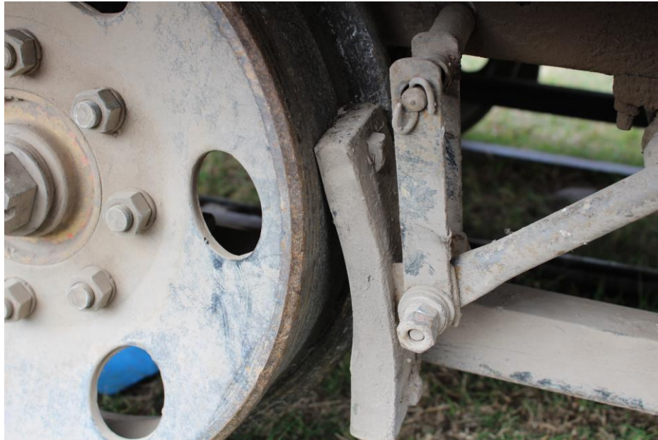
Figura 13. Zapata de freno desajustada de la rueda derecha trasera. Fuente: JST, 2021
