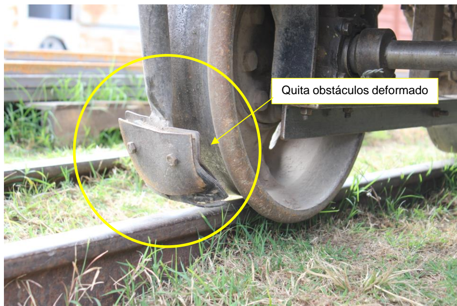
Figura 14. Quita obstáculos de la rueda derecha delantera deformado. Fuente: JST, 2021
