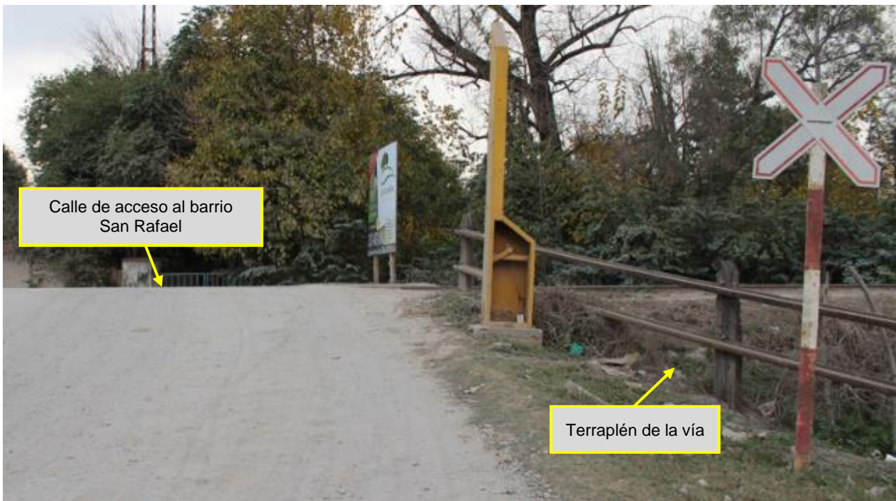
Figura 2. Paso a nivel Solís Pizarro. Fuente: JST, 2021
