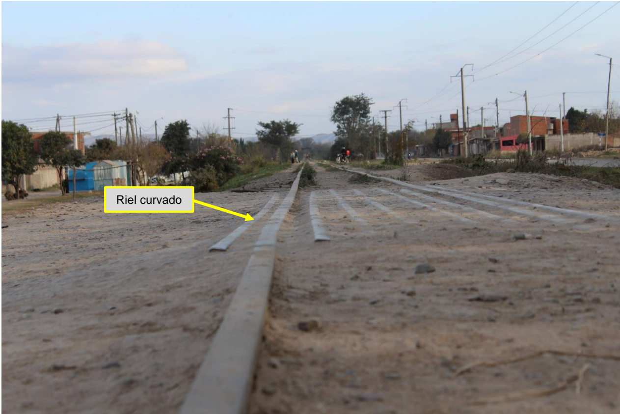
Figura 9. Curvatura del riel a la altura del paso a nivel Solís Pizarro. Fuente: JST, 2021
