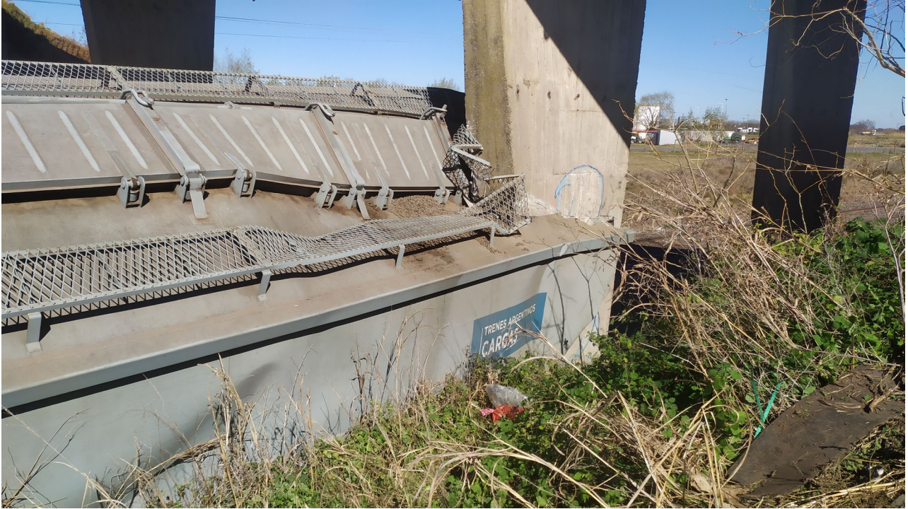
Figura 9- Vagón N°2004828 (posición 39) – vista hacia Saforcada Fuente: Investigador en el lugar del suceso.
