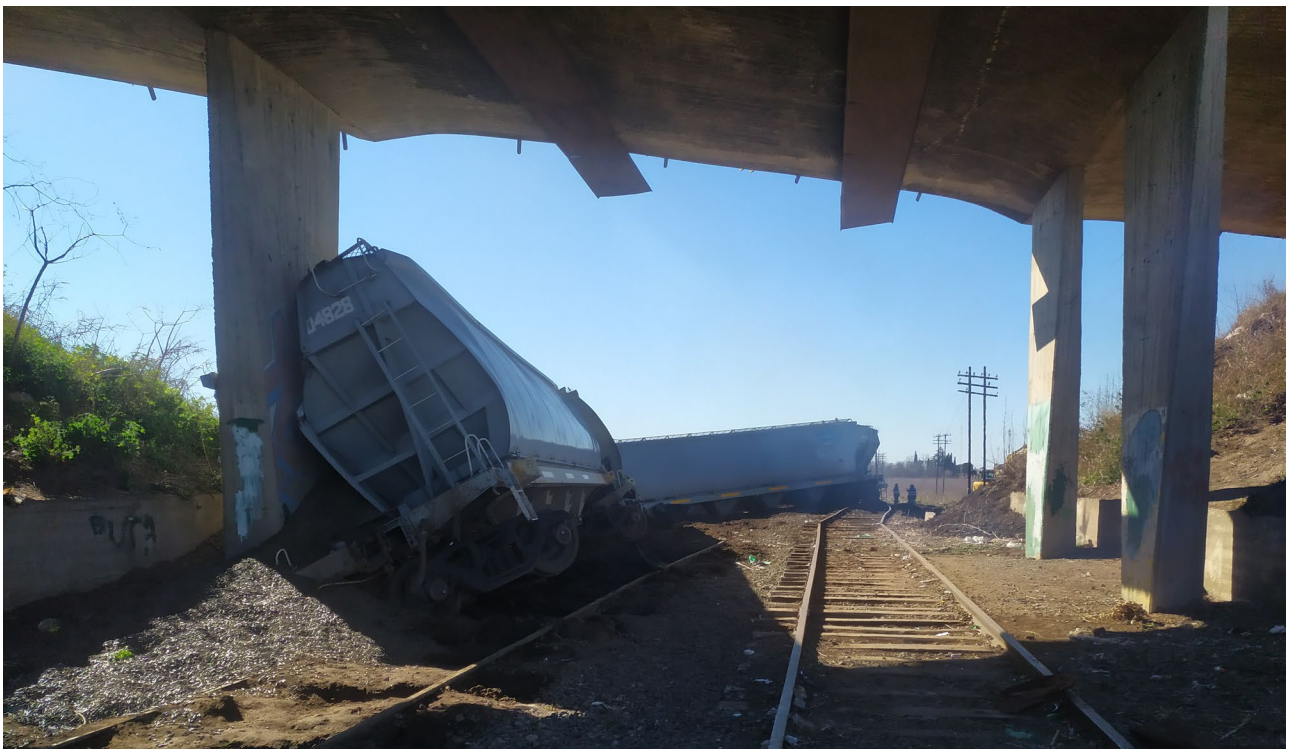
Figura 5- Vagones descarrilados pertenecientes al tren Q02, vista hacia Junín, Fuente: Investigador en el lugar del suceso.
