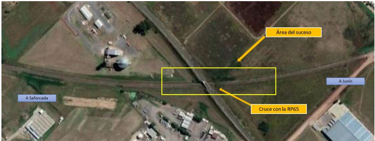
Figura 2 – Lugar del descarrilamiento, Fuente: Google Maps
