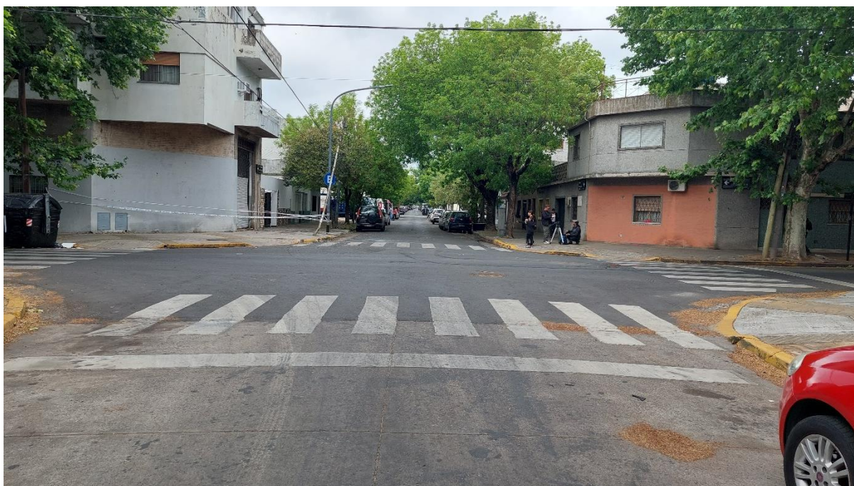
Figura 10. Señalización horizontal urbana de línea de detención, senda peatonal y cordón amarillo.
