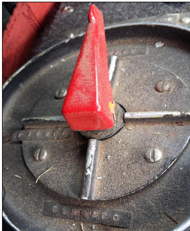
Figura 3. Llave selectora de tanques de combustible. Fuente: investigación JST
