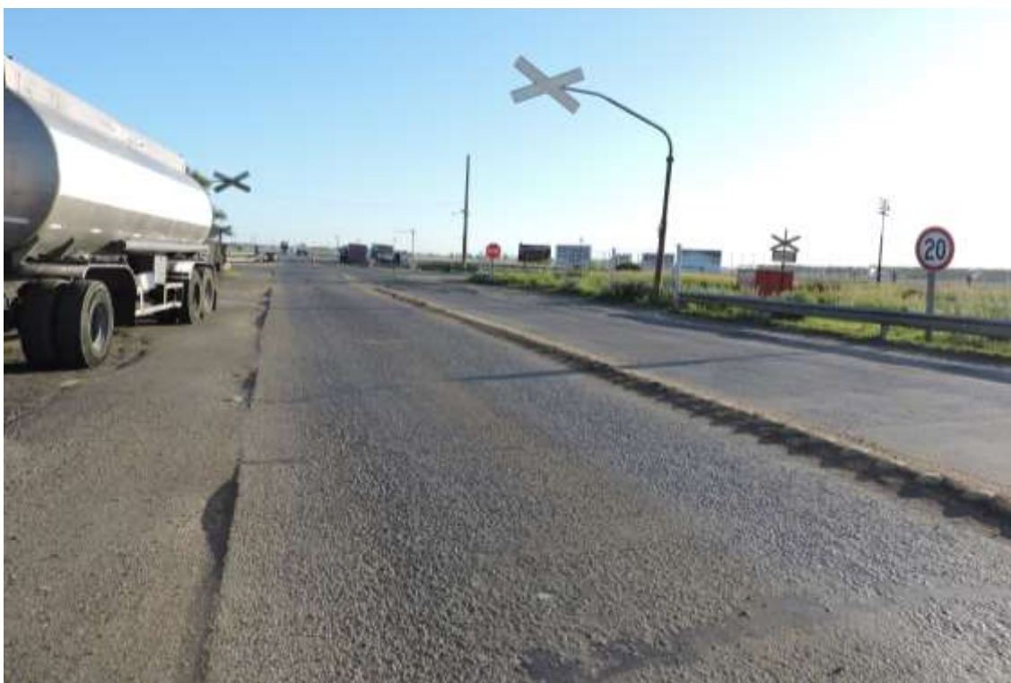
Figura 3. Ruta Nacional A012 hacia Ricardone. Señalización vial. Vehículo sobre el costado de calzada Fuente: JST, 2022
