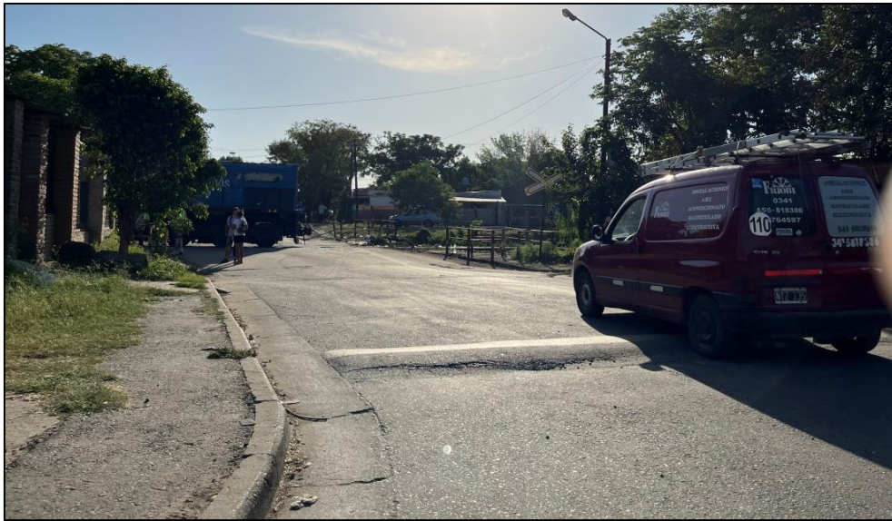
Figura 5. Reductor de velocidad, vista hacia el oeste. Fuente JST, 2023
