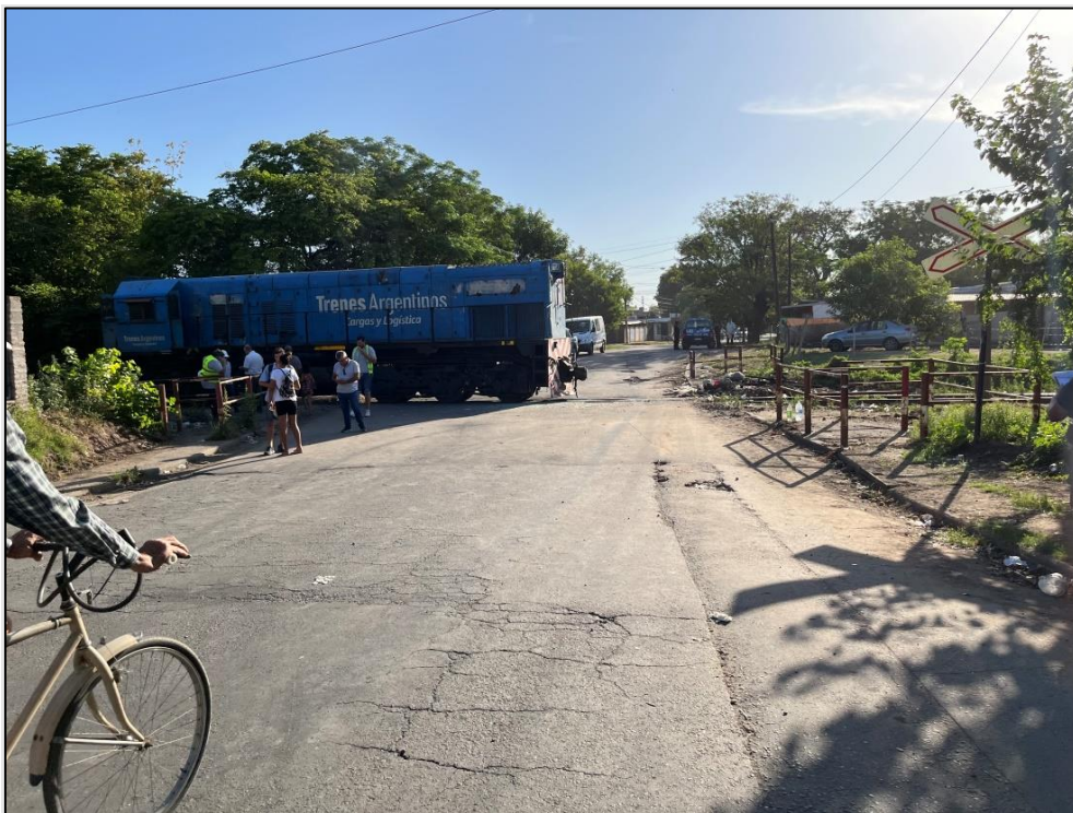
Figura 6. Visualización de la calzada vehicular con fisuras y reparaciones. Fuente: JST, 2023
