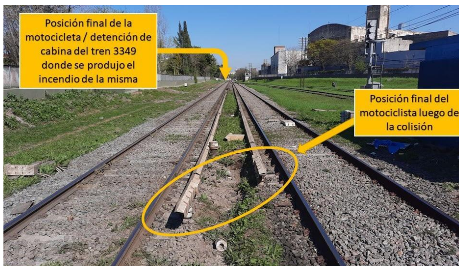
Figura 3. Vista frontal de las vías y el tercer riel. Fuente: JST, 2021
