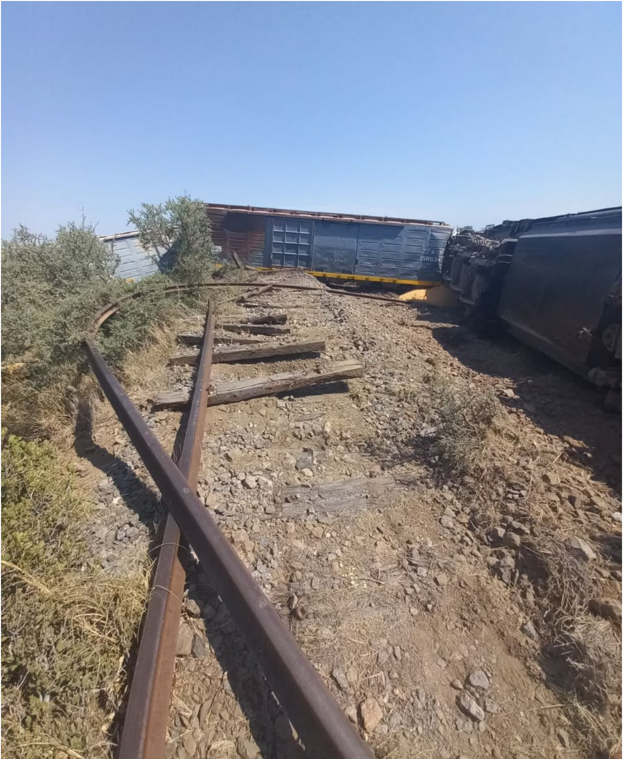
Figura 2. Arrastre de superestructura de vía y vagones descarrilados pertenecientes al tren N.º1416. Fuente: Archivo JST
