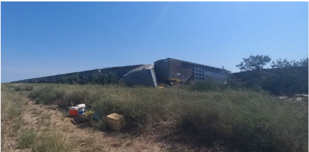
Figura 12. Primeros vagones del tren N.º 1416, descarrilados sobre el terraplén. Fuente: Archivo JST
