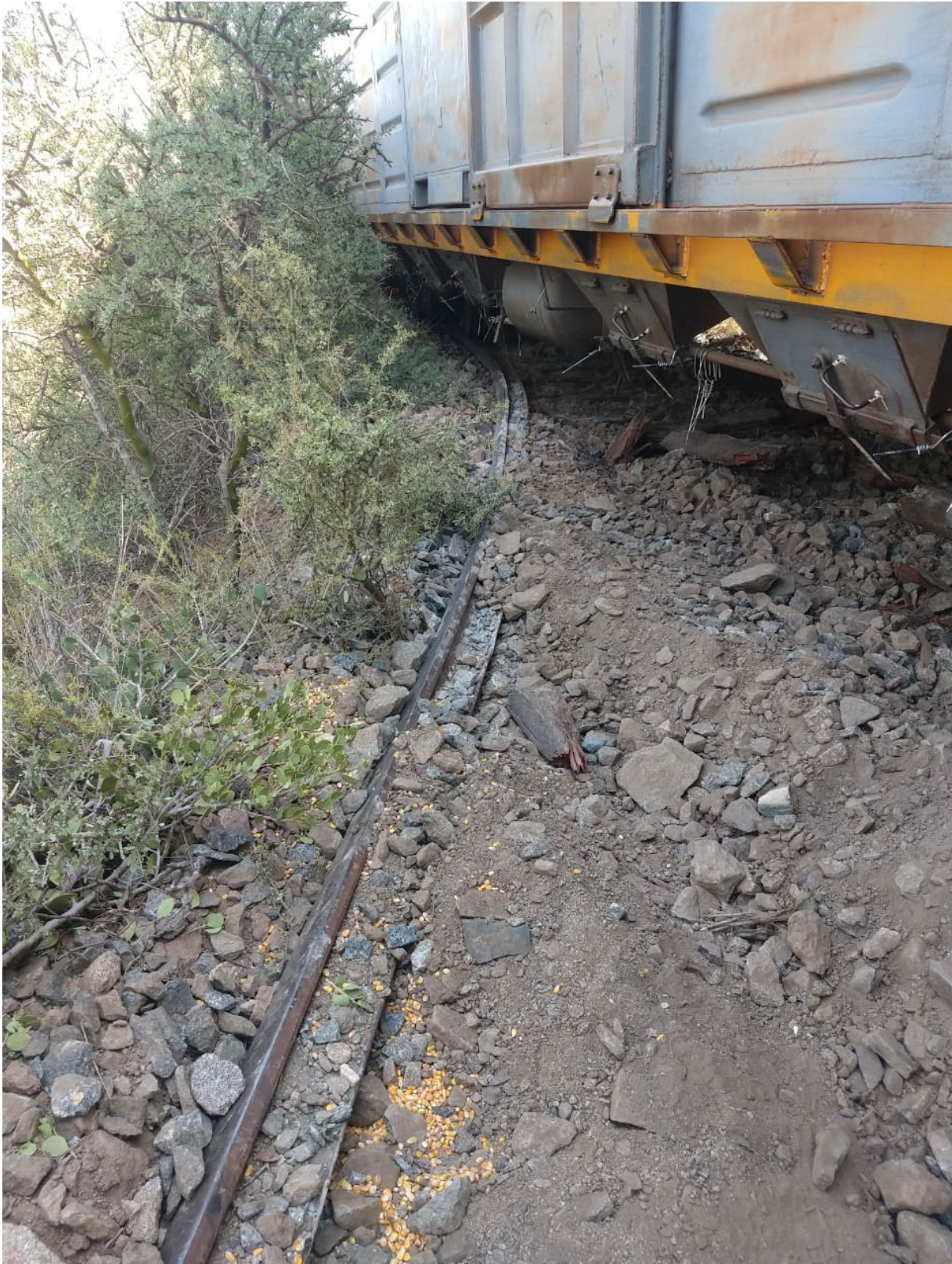
Figura 10. Estado de uno de los vagones accidentados y de la superestructura de vía luego del descarrilamiento. Fuente: Archivo JST
