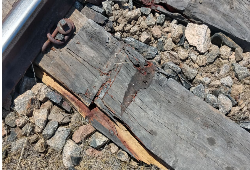
Figura 8. Marcas del paso de rueda previo al sector del suceso. Fuente: Archivo JST
