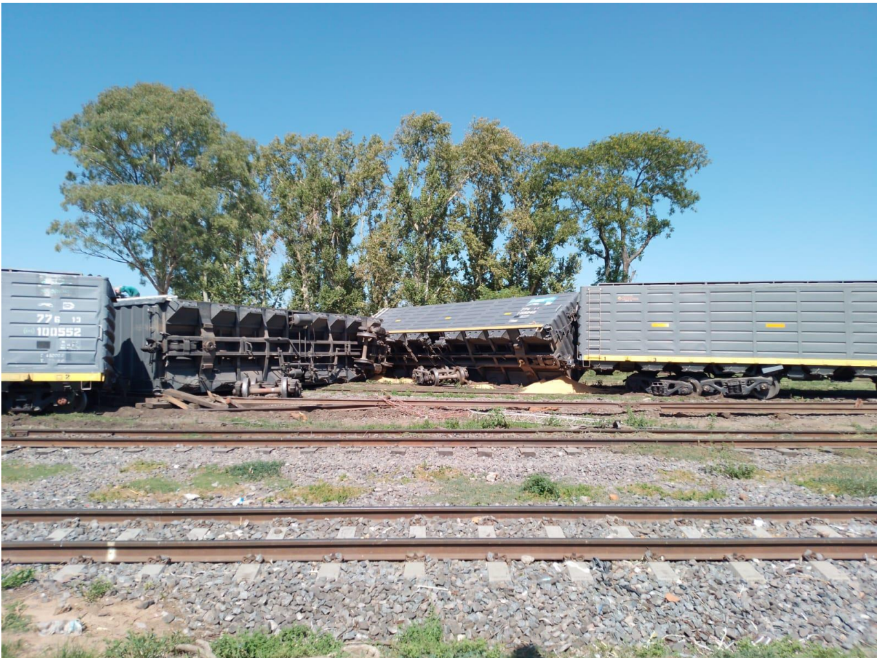
Figura 1. Vista general del descarrilamiento. Fuente: JST, 2023
