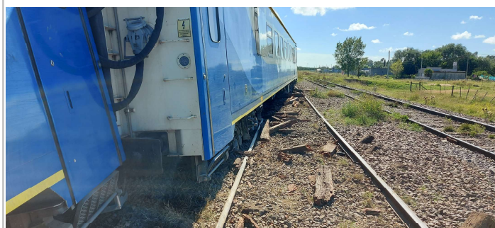
Fig.2. Vista general de los daños generados en la superestructura a causa del descarrilamiento. Fuente: JST
