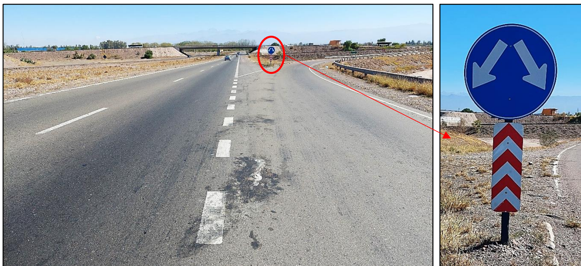
Figura 4. Aproximación a la zona del accidente. Calzada de doble carril, con carril auxiliar hacia la rama de salida de la autovía, previo al puente con Ruta Provincial 50. A la derecha, se observa señalización vertical: cartel informativo de dirección permitida en ambas direcciones y panel de prevención. Fuente: JST, 2023
