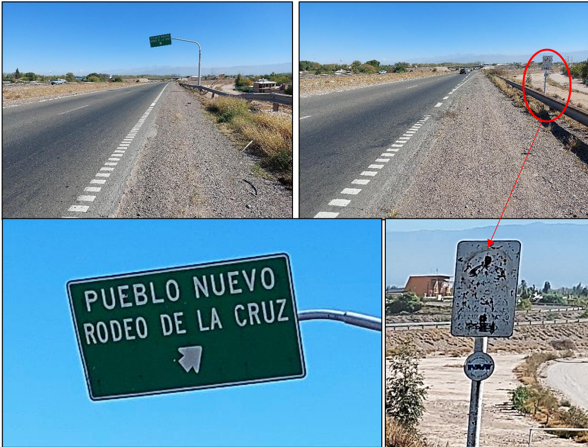
Figura 3. Vista general de Ruta Nacional 7 mano hacia Mendoza (este a oeste). Se observa señalización vial vertical y horizontal, previo a la zona del accidente. Fuente: JST, 2023
