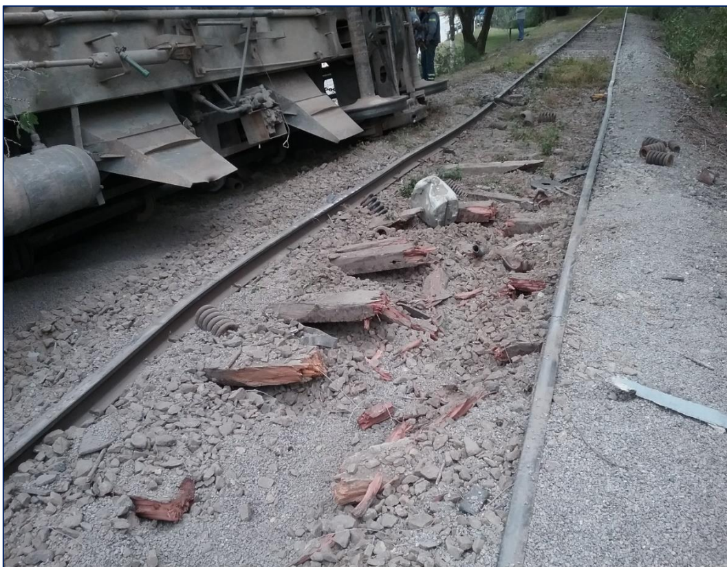
Figura 4. Durmientes de madera dañados y piezas de suspensión dispersas sobre la vía. JST, 2023
