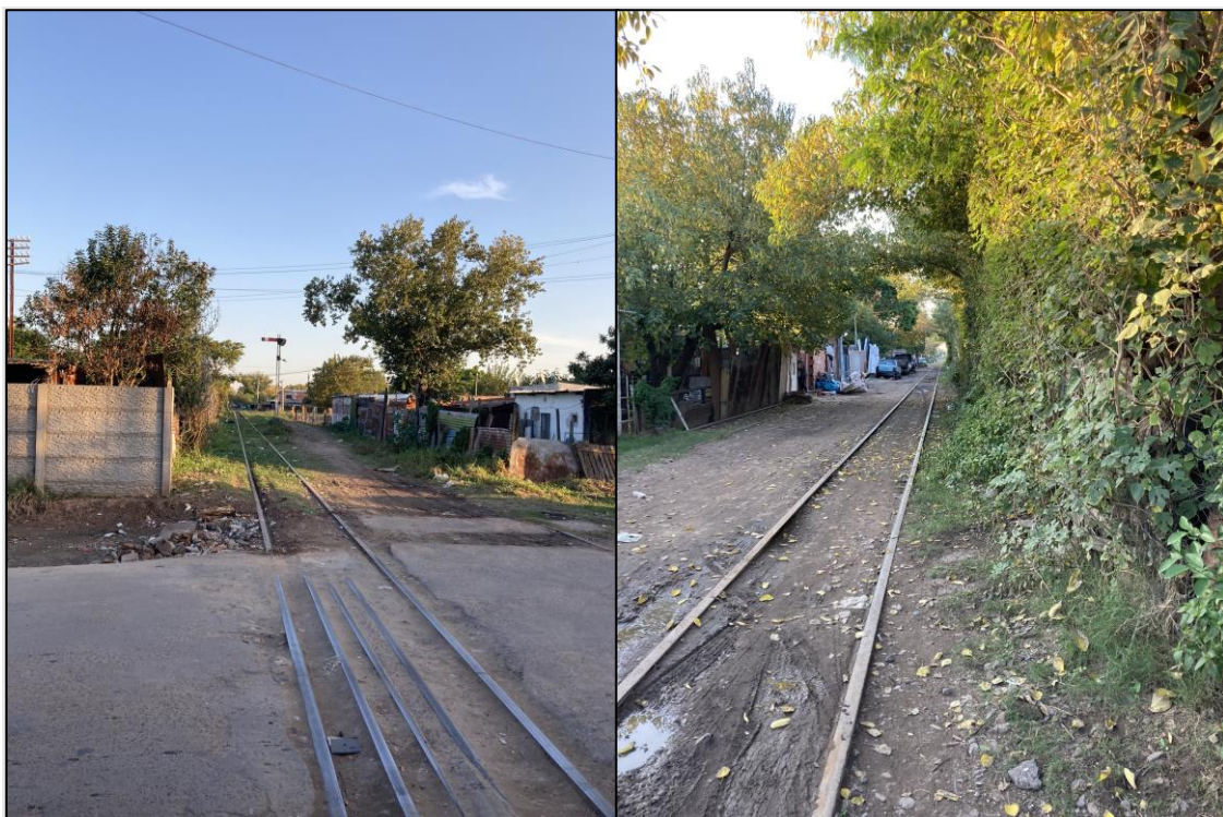
Figura 6. Invasión de vegetación y edificaciones. Fuente: JST, relevamiento de abril de 2023
