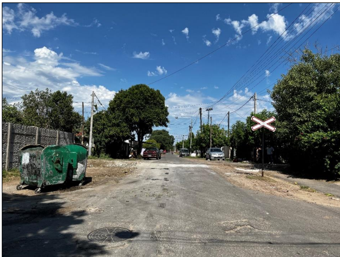
Figura 8. Presencia de Cruz de San Andrés. Visibilidad obstaculizada
