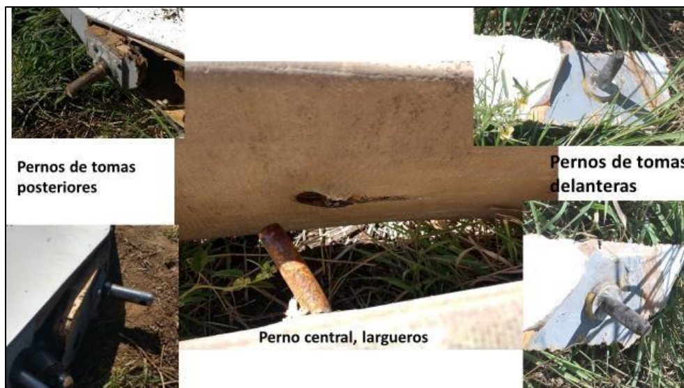
Figura 13. Detalle de pernos de unión. Fuente: investigación JST
