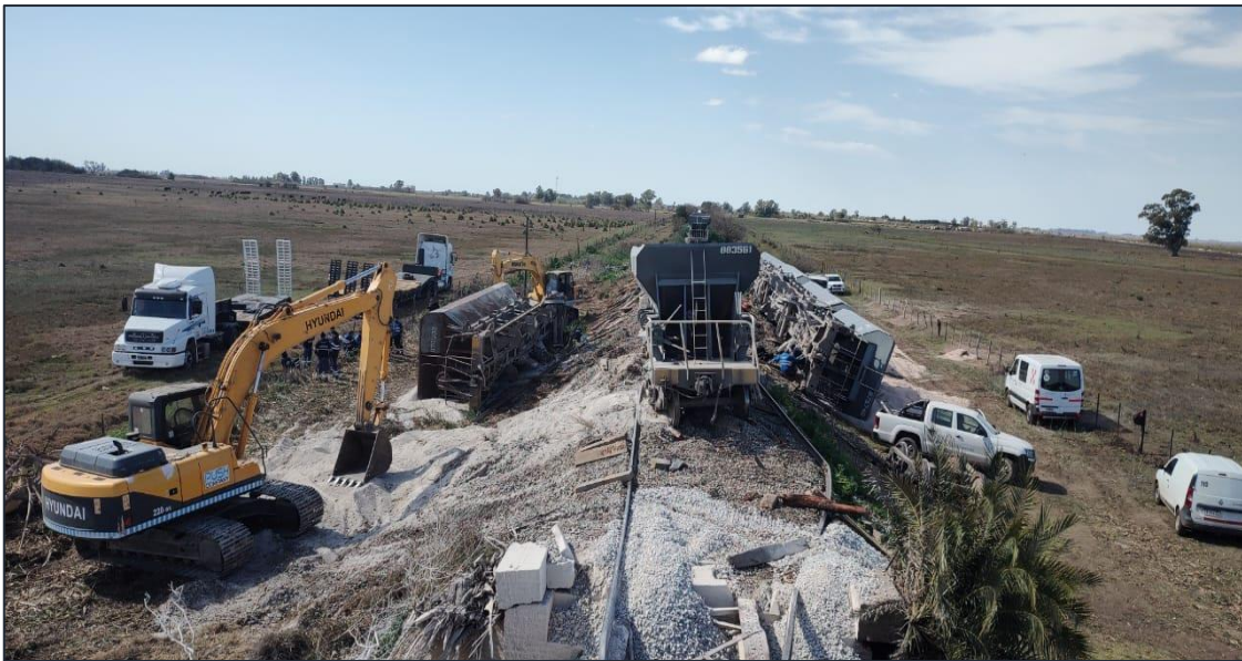
Figura 4. En la imagen se observa a los equipos de trabajo realizando las tareas necesarias para la restitución del servicio. Fuente: JST, 2023
