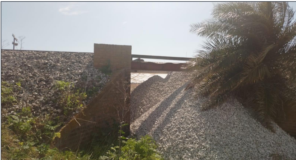
Figura 2. Obra de arte (ODA) involucrada en el suceso y pérdida de carga de uno de los vagones volcados. Fuente: JST, 2023
