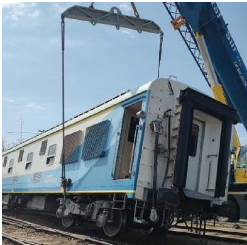
Figura 2. Tareas de encarrilamiento. Fuente: JST, 2022
