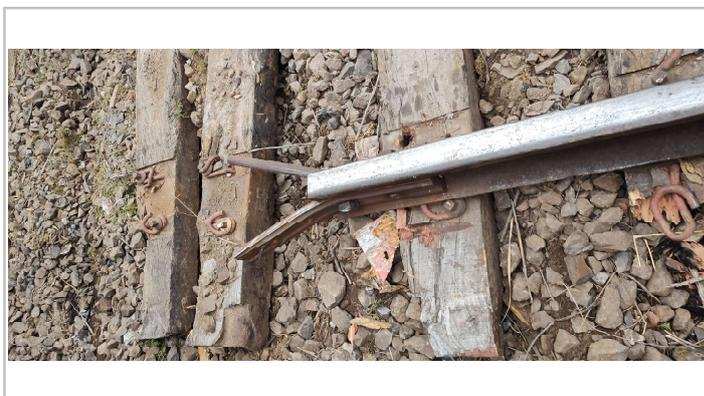
Figura 4. Daños en la superestructura. JST, 2023
