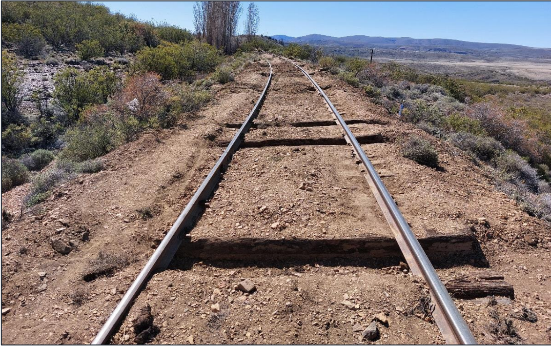
Figura 6. Trabajos en la curva anterior a la zona del suceso registrados durante el relevamiento del 12 de octubre de 2023. Fuente: JST, 2023
