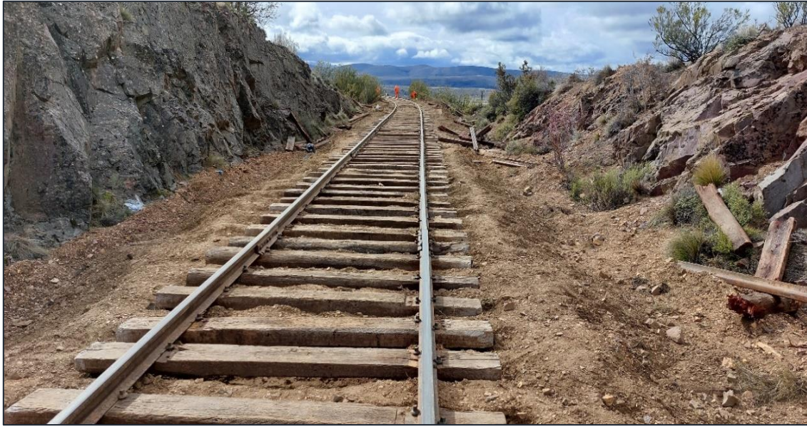
Figura 4. Trabajos de vía en la zona del suceso observados durante el relevamiento del 27 de septiembre de 2023. Fuente: JST, 2023
