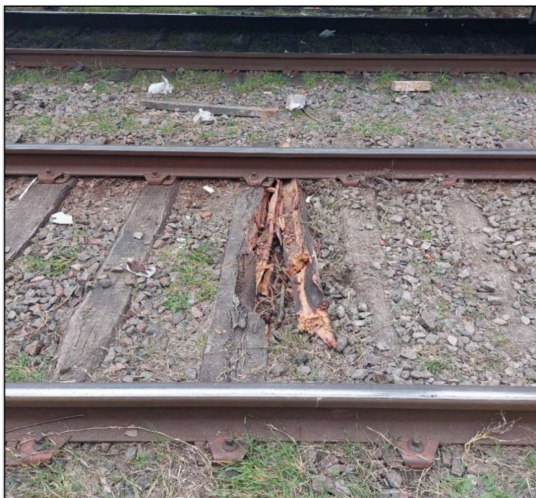
Figura 8. Daños en durmiente. Fuente: JST, 2023
