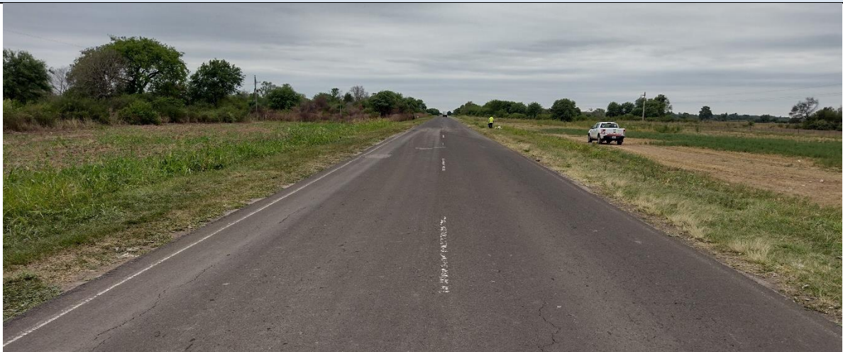
Figura 1. Vista panorámica del tramo de la Ruta Nacional 95 donde se desarrolló el impacto. La imagen fue capturada siguiendo el sentido de avance hacia la ciudad de Presidencia Roque Sáenz Peña. Fuente: JST, 2023
