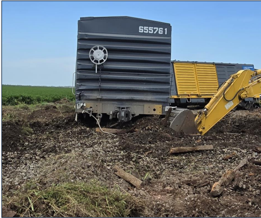
Figura 1. Vagones descarrilados pertenecientes al tren G10. Fuente: JST, 2024
