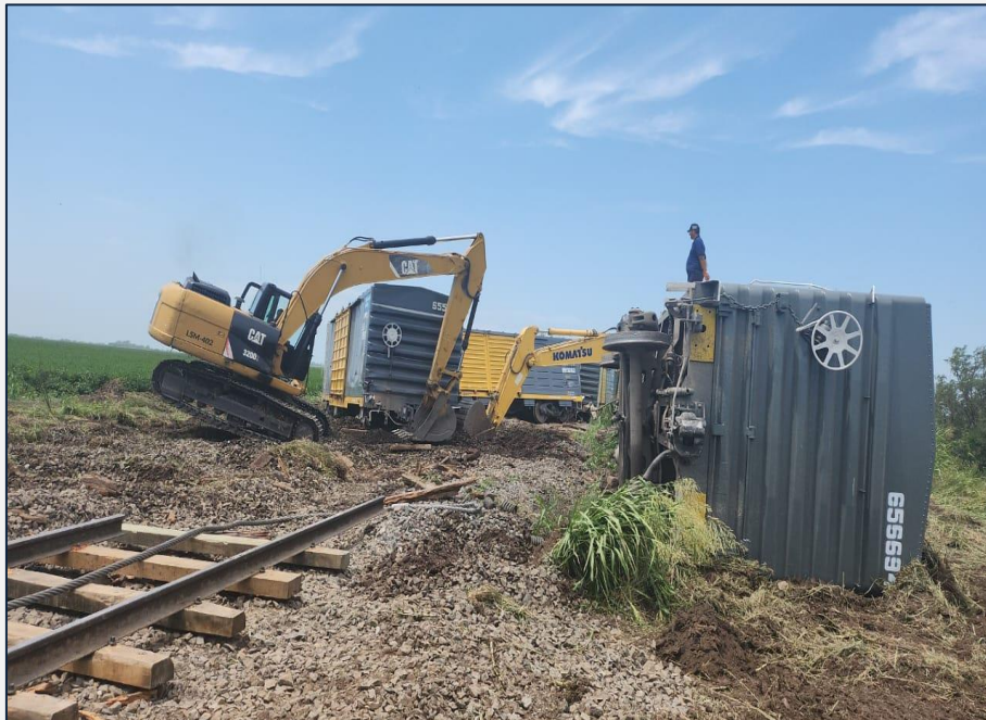
Figura 2. Remoción del material rodante y tareas de reparación de superestructura de vía. Fuente: JST, 2024
