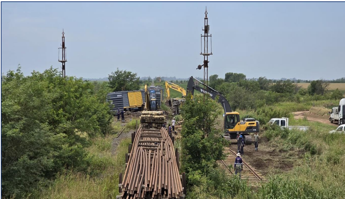
Figura 2. Tareas de encarrilamiento de vagones y reparación de la superestructura.
