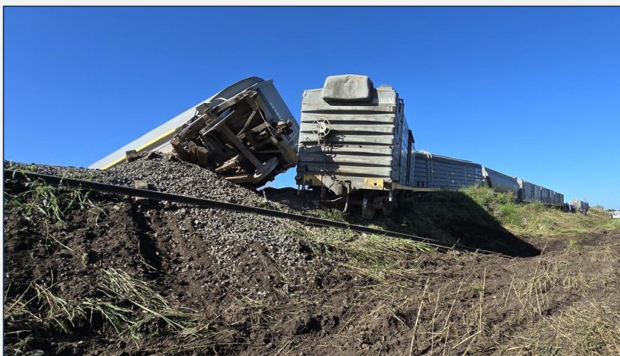
Figura 3. Vagones descarrilados y arrastre de superestructura de vía. Fuente: JST, 2024
