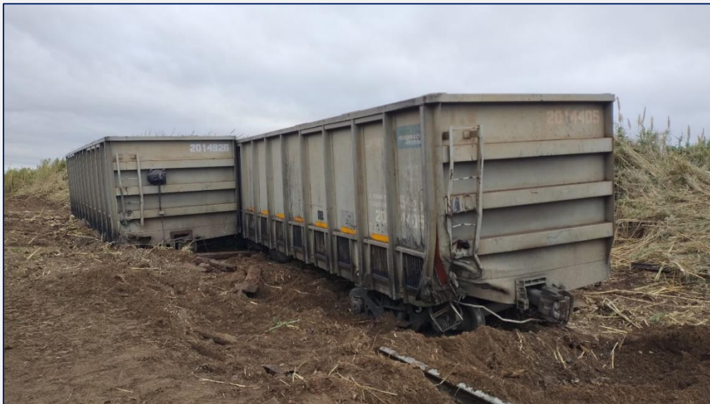
Figura 2. Vagones descarrilados y daños en la superestructura de vía. Fuente: JST, 2024.
