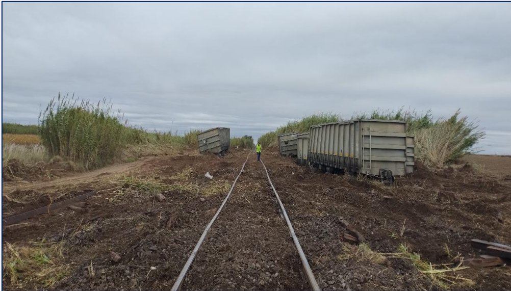
Figura1.Vista general del descarrilamiento del tren C28 en sentido a Palmira. Fuente: JST, 2024
