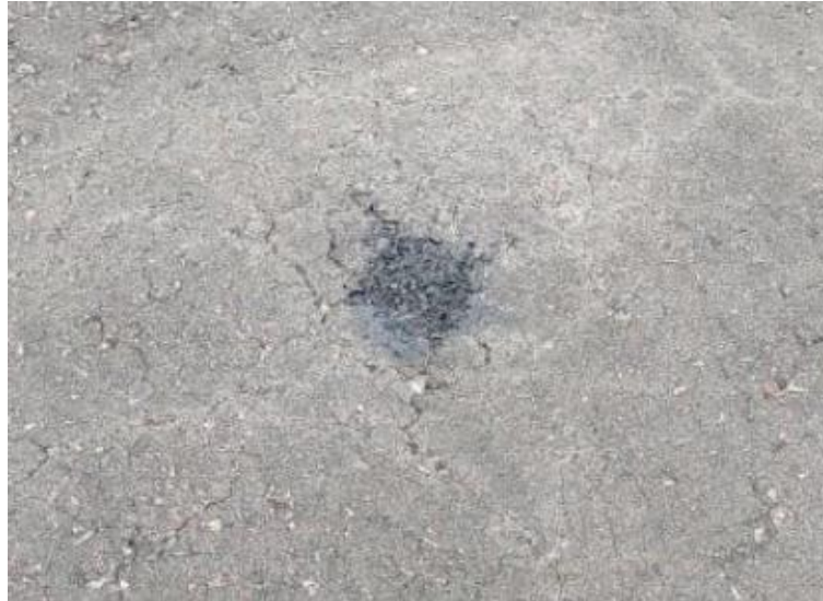
Figura 21. Bache detectado en la pista 17/35. Fuente AA 2000
