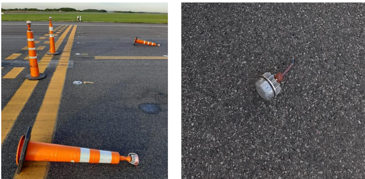
Figura 1. Daños experimentados por los conos. Fuente: Control Terrestre del Aeropuerto Internacional Ministro Pistarini
