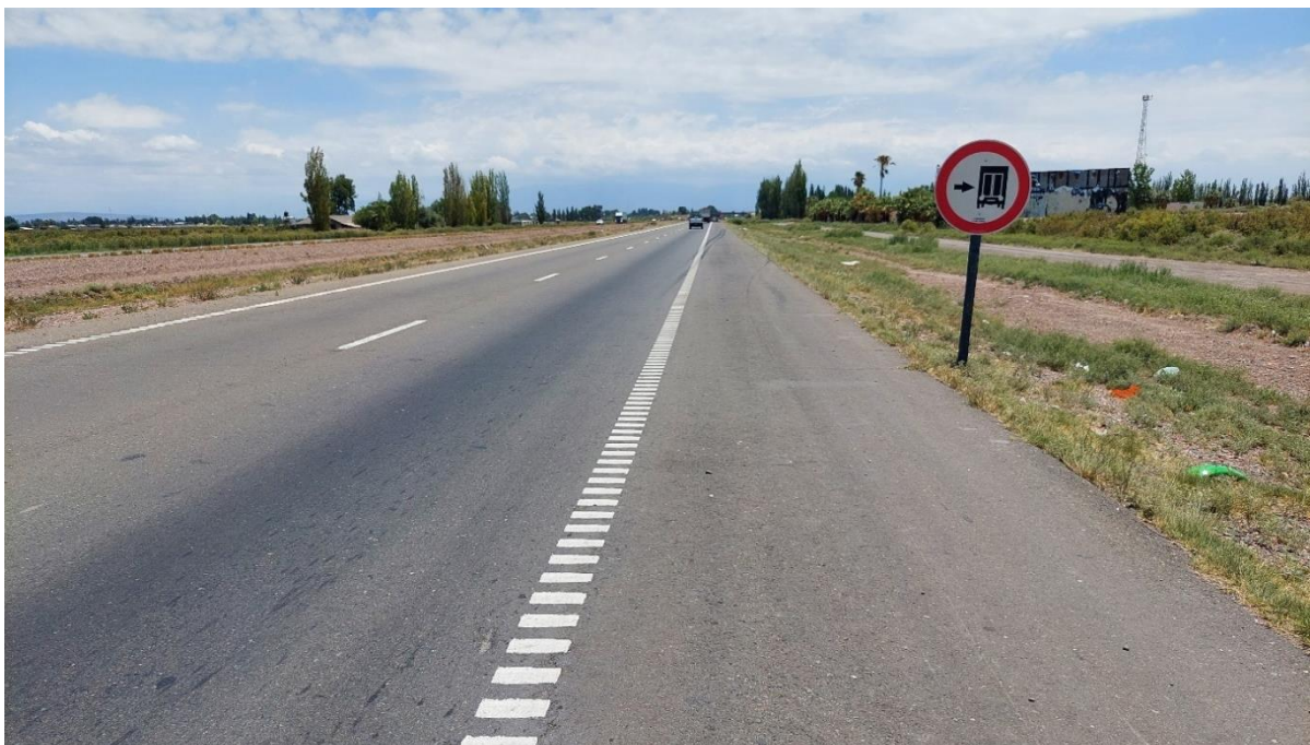
Figura 4. Cartel vial lateral de “tránsito pesado a la derecha”. Fuente: JST, 2024
