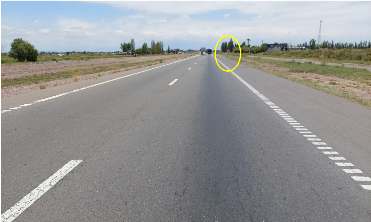
Figura 3. Vista general del lugar del accidente en Ruta Nacional 7 hacia el oeste. Dentro del círculo se indica la presencia de un cartel vial lateral de “tránsito pesado a la derecha”. Fuente: JST, 2024
