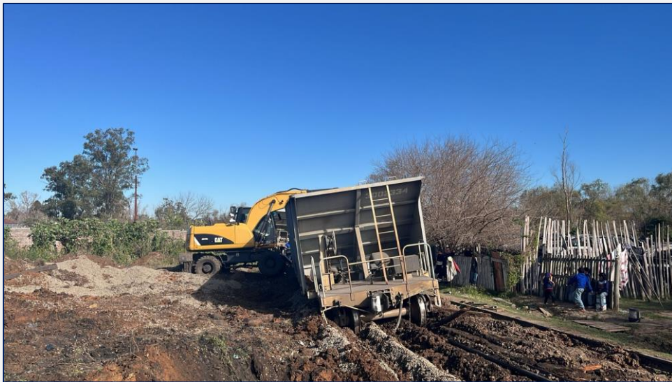
Figura 2. Retroexcavadora en tareas de encarrilamiento de un vagón. Fuente: JST, 2024
