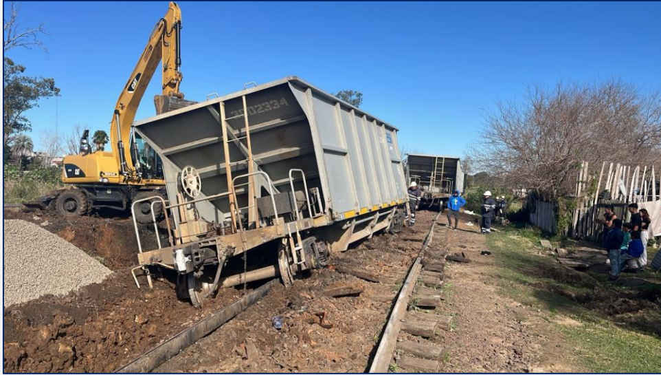
Figura 1. Vagón descarrilado del tren N06 con pérdida de carga. Fuente: JST, 2024
