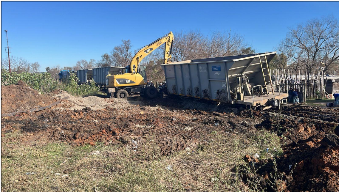
Figura 2. Retroexcavadora en tareas de encarrilamiento de uno de los vagones afectados. Se observa el terreno húmedo en los márgenes de la vía. Fuente: JST, 2024
