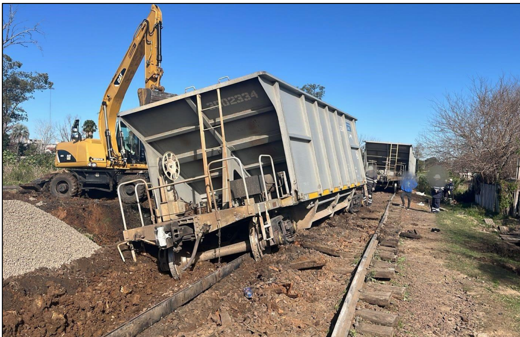
Figura 1. Vagones descarrilados y piedra partida al costado de la vía. Se observa la superestructura húmeda y desestabilizada, así como durmientes y rieles dañados. Fuente: JST, 2024
