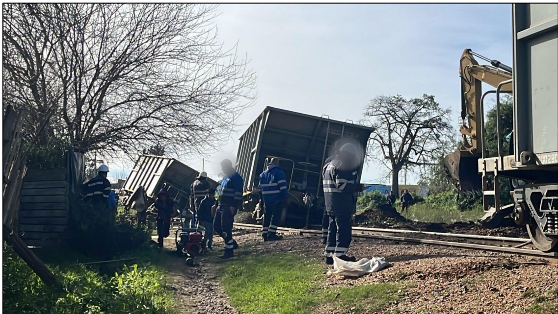
Figura 3. Dos vagones descarrilados. Fuente: JST, 2024
