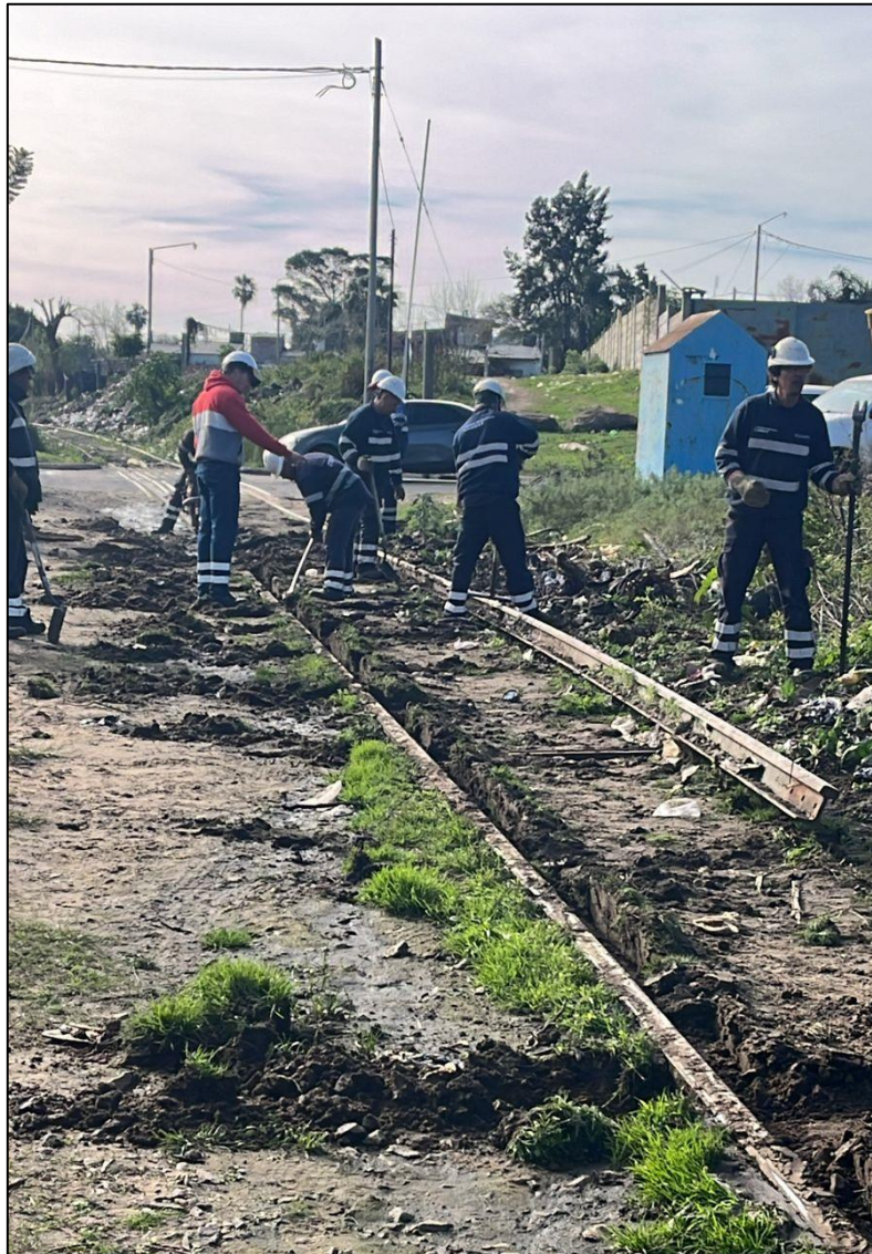
Figura 7. Personal de Vía y Obras realizando tareas de subsanación de daños.
