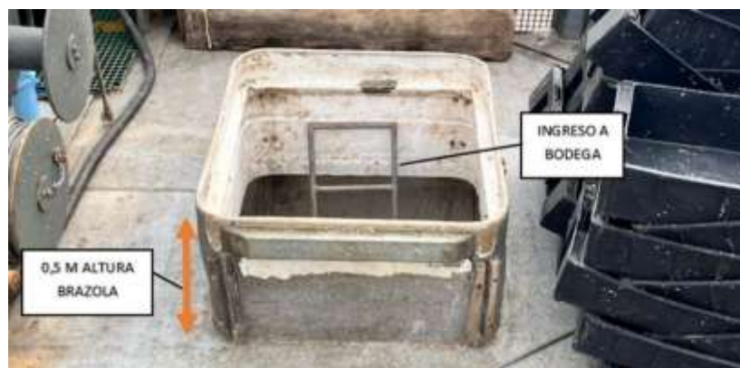
Figura 12. Ingreso a la bodega del B/P Innovator
