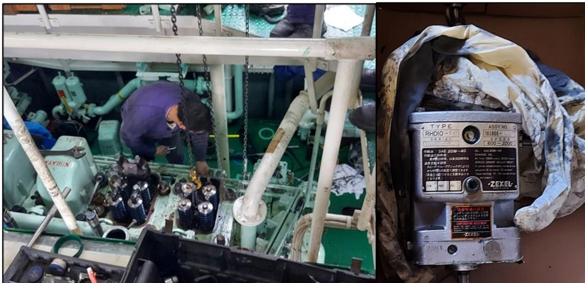
Figura 13. A la izquierda se observa las tareas de desmontaje del regulador de velocidad y de los movimientos N° 1 y N° 2 del motor principal de babor. A la derecha se ve el regulador de velocidad una vez desmontado del motor principal de babor
