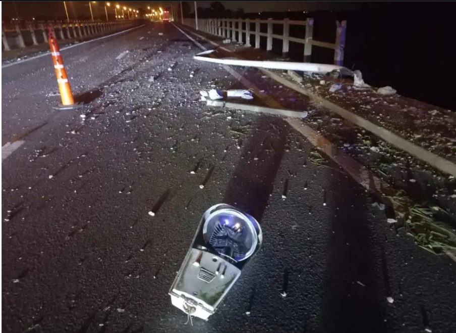
Figura 1. Lugar del choque y salida de vía sobre el puente. Fuente: Sol Playa 91.5 , 2024
