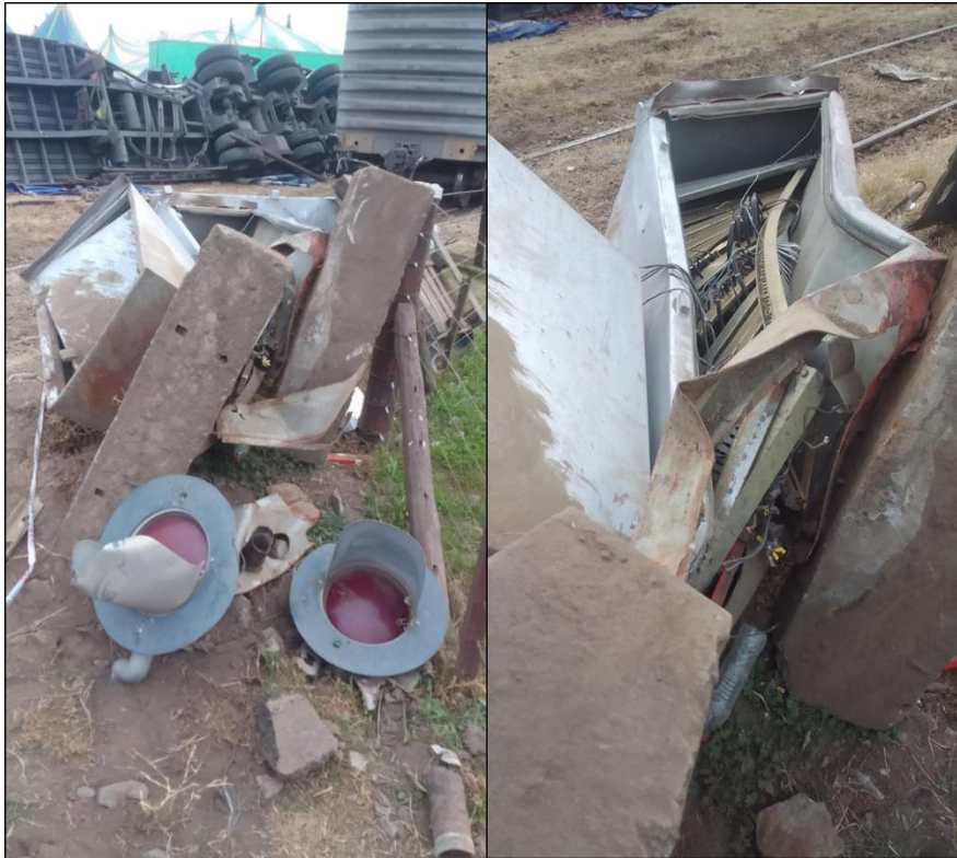
Figura 11. Instalación de barrera y señales fonoluminosas destruida. Fuente: BCyL, 2024
