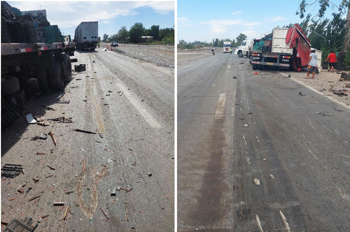
Figura 14. Trayectoria posimpacto del Vehículo 2. A la izquierda (vista hacia San Juan) se observa una huella de frenado dual y a la derecha (vista hacia Ciudad de Mendoza) la misma huella de frenado dual junto con hendiduras lineales intermitentes sobre la calzada. Fuente: JST, 2024
