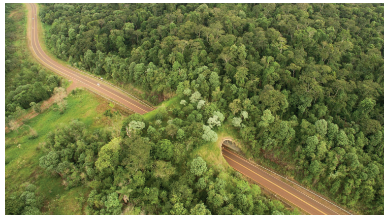
Figura 3. Ecoducto de Misiones, vista aérea
