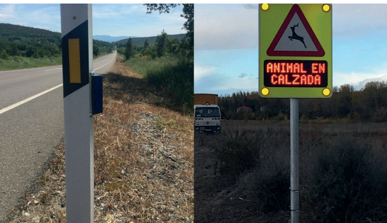
Imagen 2. Dispositivos artificiales de disuasión y señalética inteligente.
