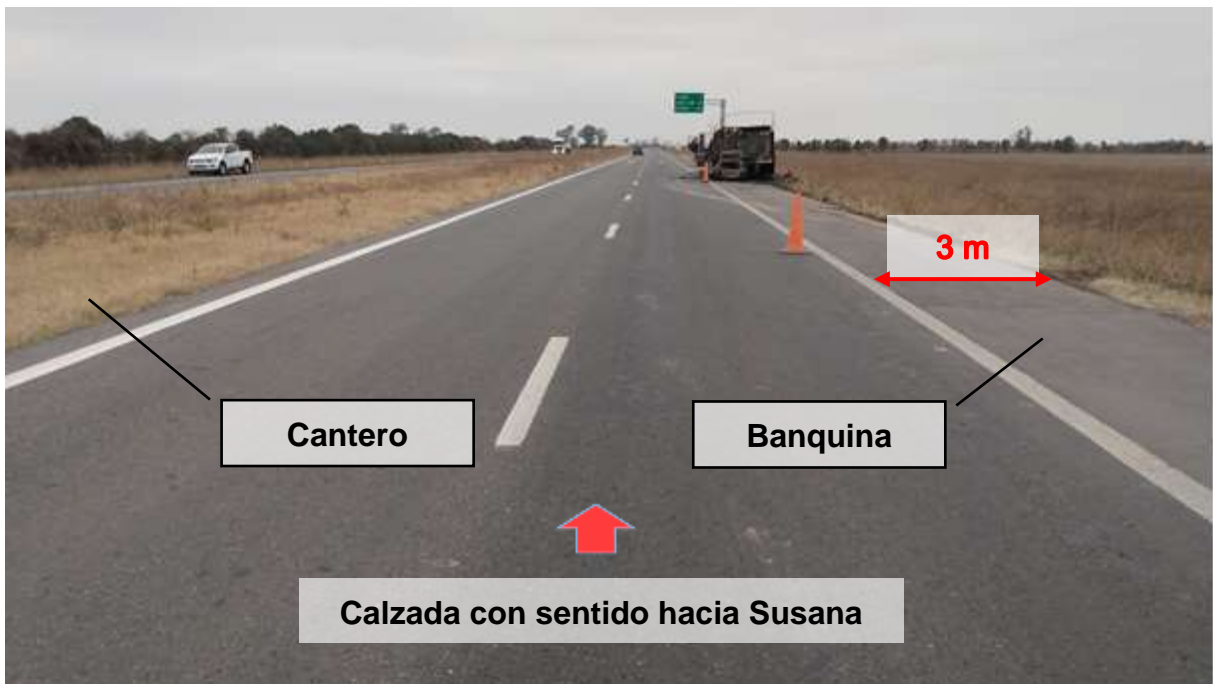
Figura 4. Características da la banquina. Fuente: JST, 2024
