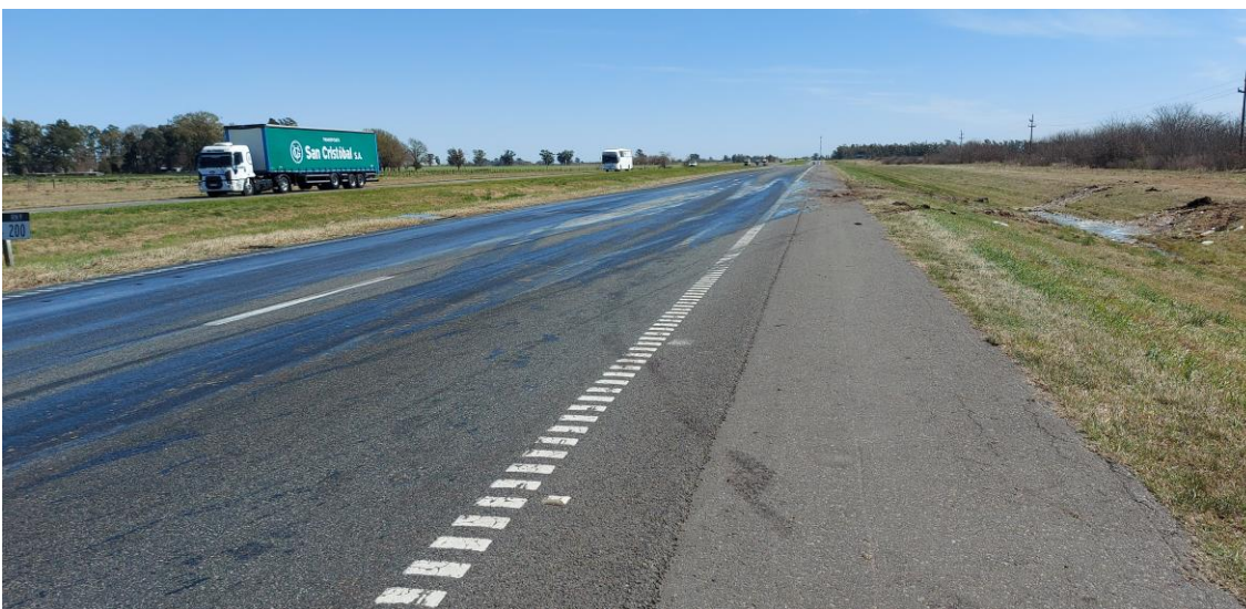
Figura 11. Derrame de glucosa y huellas en la calzada. Fuente: JST, 2024
