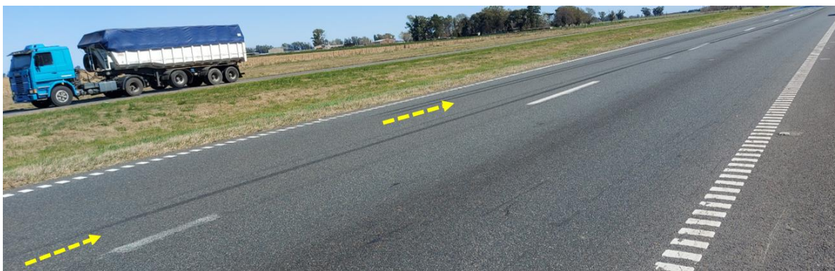
Figura 9. Se muestran con flechas punteadas, inicio y dirección de las huellas de neumáticos sobre el carril interno. Fuente: JST, 2024
