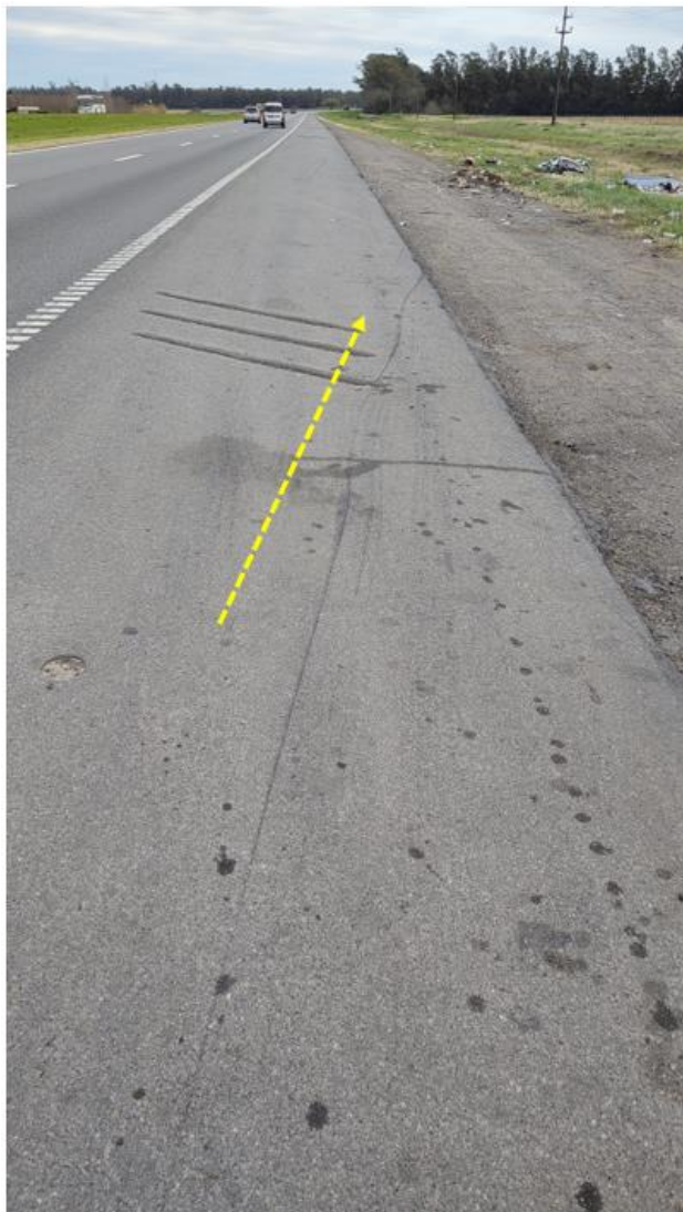
Figura 9. Ingreso del camión rígido a la banquina y al terreno lindante. Fuente: JST, 2024
