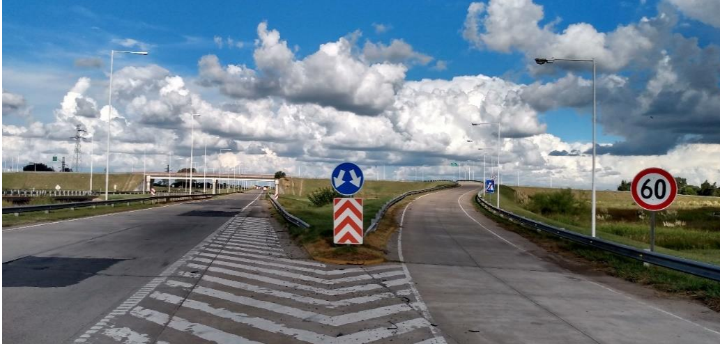
Figura 8. Autopista y acceso a distribuidor, vista hacia el cardinal este. Fuente: JST.
