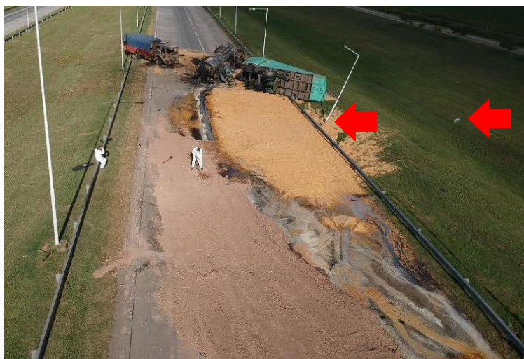
Figura 19. Daños en la infraestructura: daños en el poste y luminaria proyectada hacia la zona de préstamo. Vista hacia el cardinal este. Fuente: JST.
