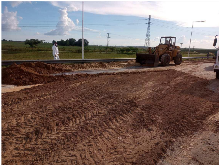
Figura 9. Tareas de remediación en el lugar del suceso
