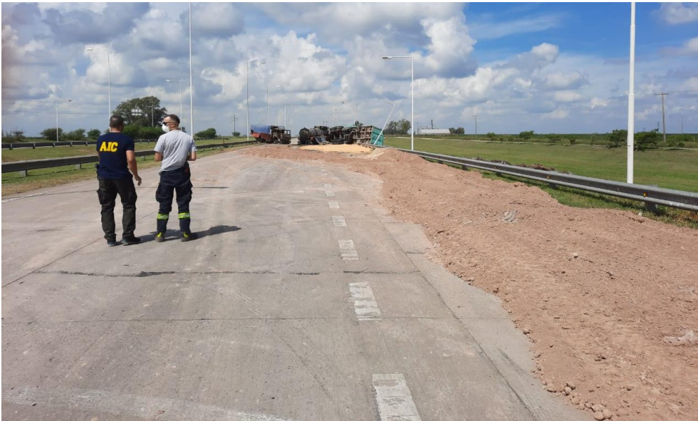
Figura 10. Señalamiento horizontal de la vía
