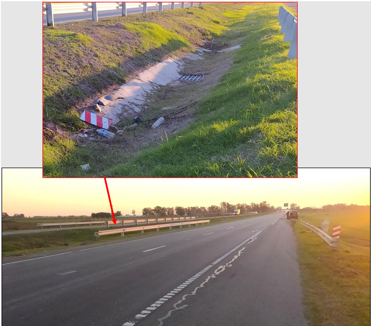
Figura 10. Fotografía de paneles de prevención delante de las barreras de contención lateral. Fuente: JST
