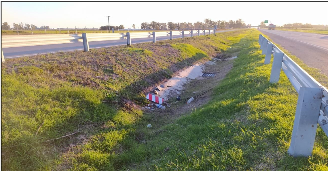
Figura 12. Alcantarilla en cantero central. Fuente: JST
