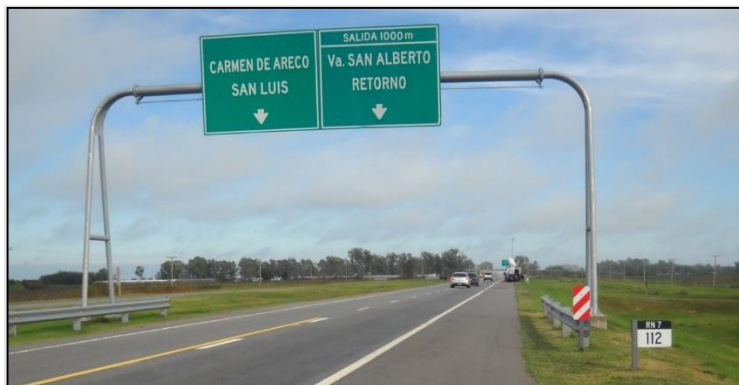
Figura 9. Fotografía de la señalización vertical previa al lugar del suceso conformada por cartel de progresivo kilométrico 112, paneles preventivos, cartel de señalización informativa aérea. Fuente: JST
