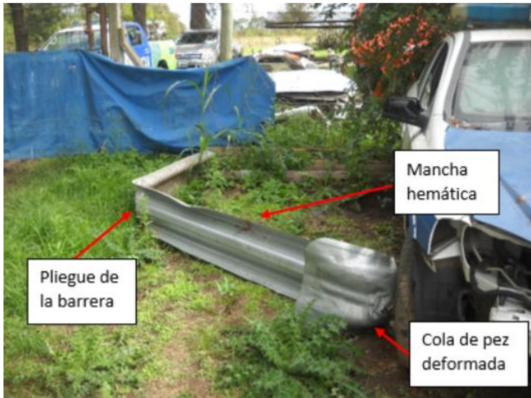
Figura 13. Tramo de la barrera desprendido. Fuente: JST, 2021
