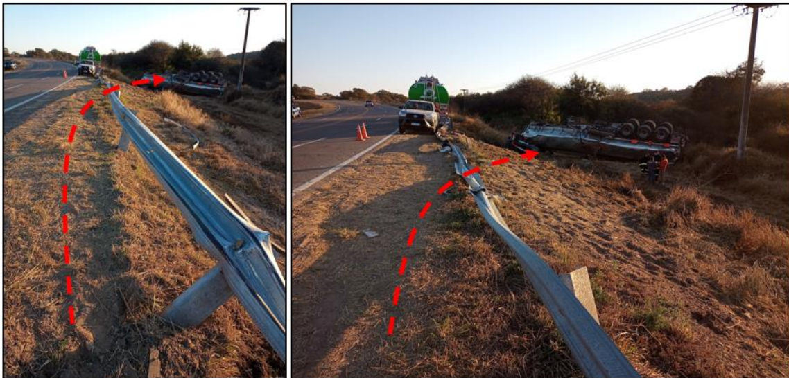
Figura 11. e) Fricciones en cara interna de barrera por el contacto con el lateral del camión; f) Sector de guardrail deformado y aplastado por el paso del camión y semirremolque durante el vuelco en tonel. Fuente: JST.
