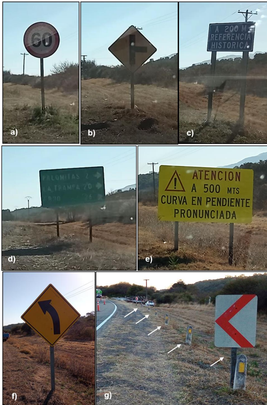
Figura 5. Señalización vertical documentada, en sentido sur a norte: a) Cartel prescriptivo de velocidad máxima; b) Cartel preventivo de "empalme"; c) Cartel informativo; d) Cartel informativo de orientación de destino; e) Cartel preventivo de proximidad de curva peligrosa; f) Cartel preventivo de "curva amplia a la izquierda" y g) Paneles de prevención simples y postes reflectivos. Fuente: JST.
