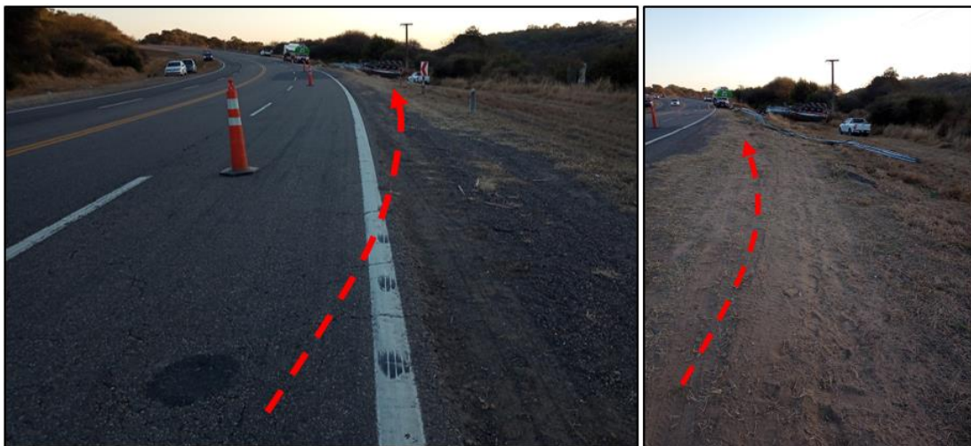
Figura 9. a) Sector por donde el camión comienza a despistar y b) sector de la banquina por donde despista y luego impacta el lateral interno de la barrera. Fuente: JST.
