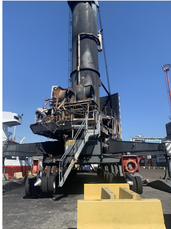
Figura 19. Vista de frente de los restos de la grúa incendiada.
