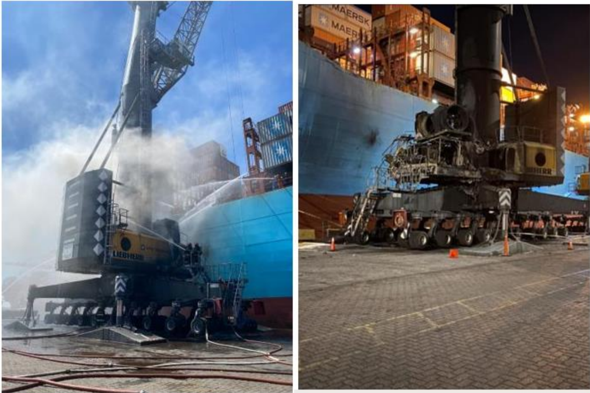
Figura 4. Vista de los daños de la Grúa MHC 07.
