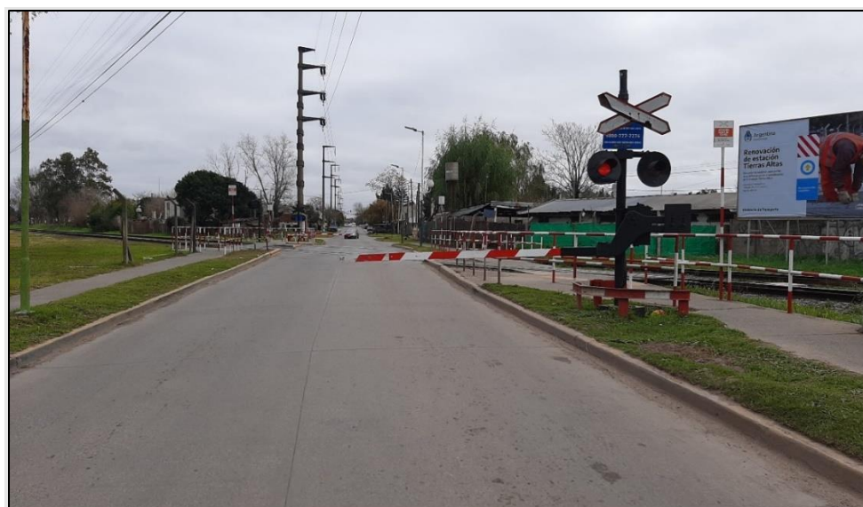
Figura 23. Calzada Cura Brochero (sentido SE-NO). Ausencia de línea de detención
