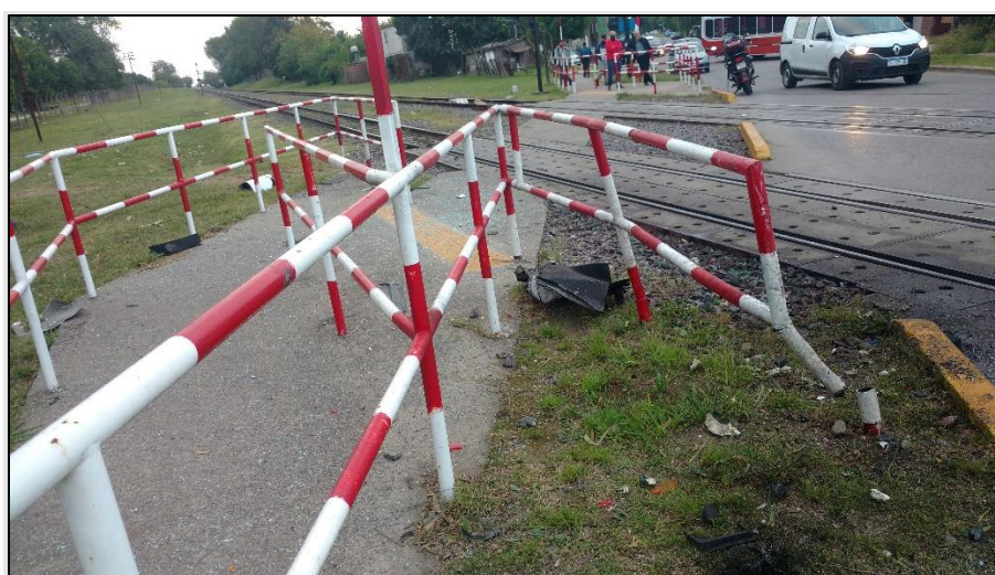
Figura 8. Laberinto peatonal dañado luego del accidente
