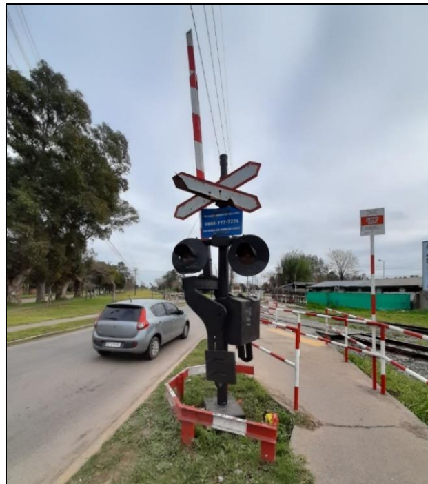
Figura 27. Cruz de San Andrés vertical sobre barreras automáticas. Fuente: JST, 2021
