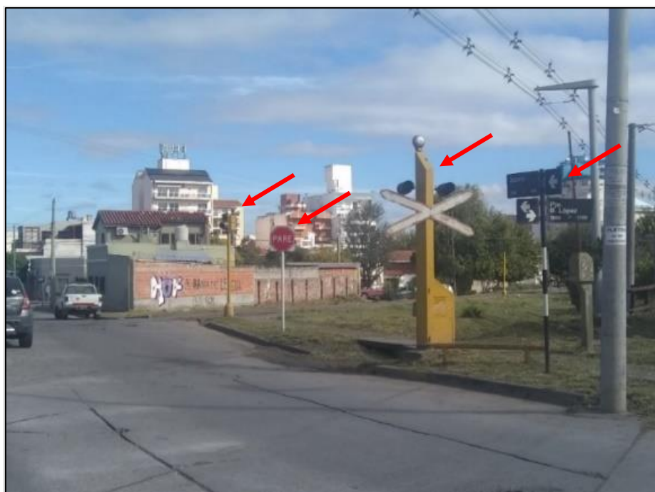
Figura 19. Cartel nomenclador, Cruz de San Andrés, cartel de “PARE” y semáforo (sin funcionar). Vista hacia cardinal sur/sentido N-S
