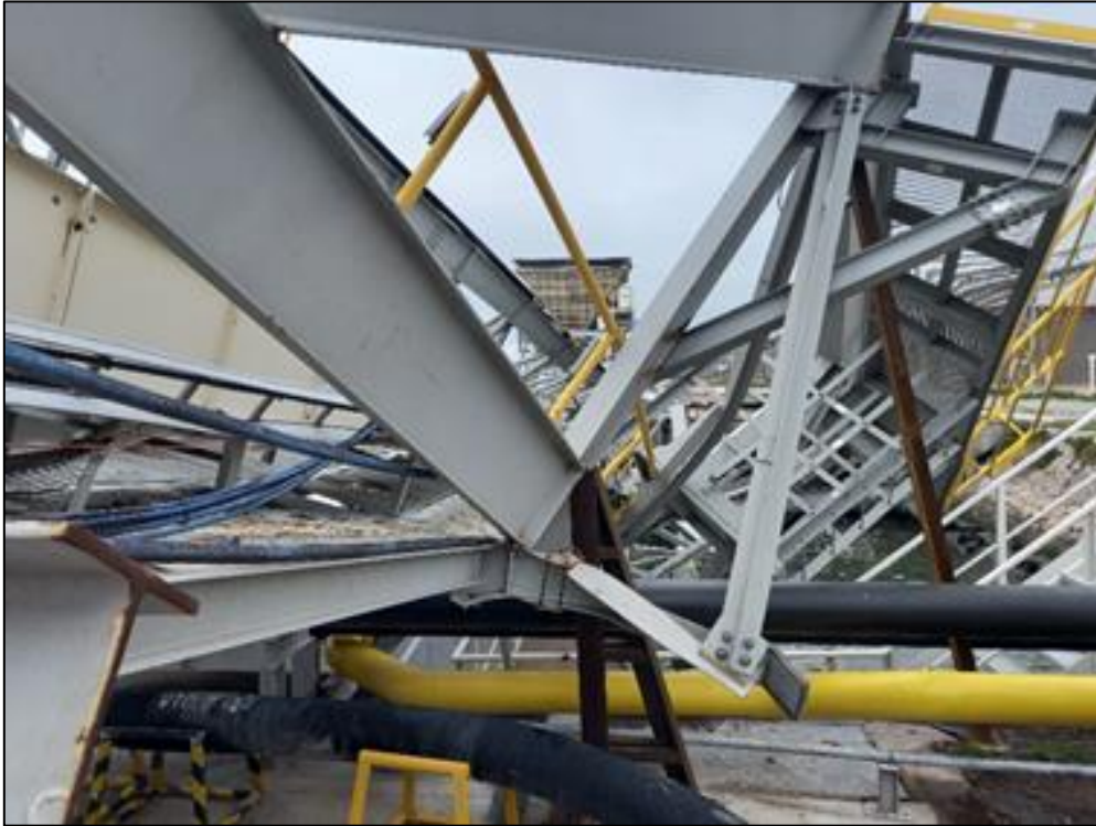
Figura 12. Apuntalamiento de la estructura. Fuente: JST, septiembre de 2021
