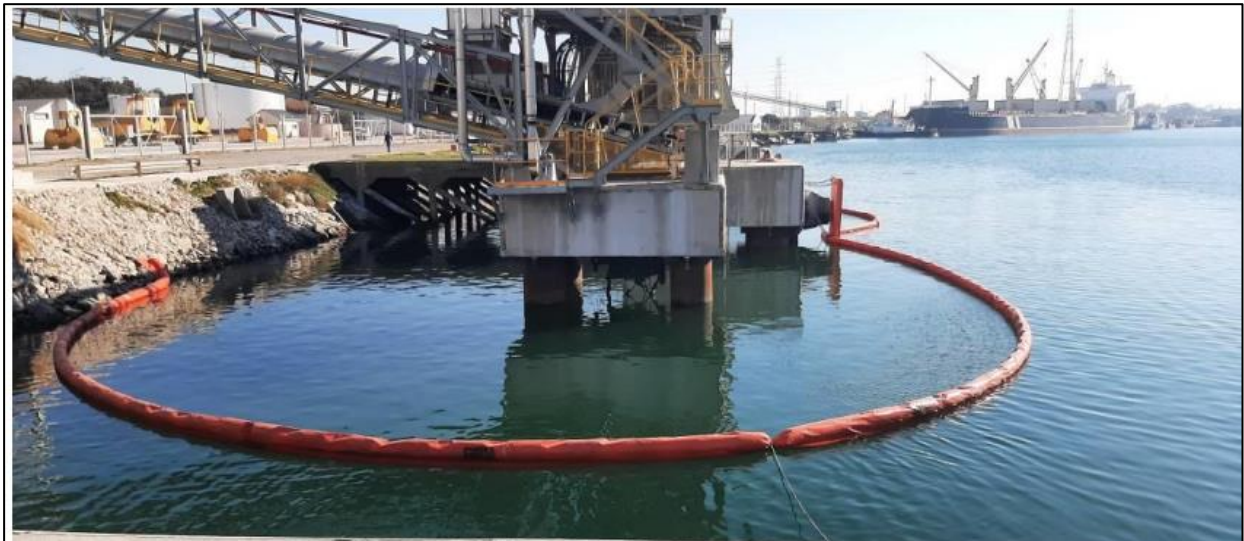
Figura 13. Barreras de contención. Fuente: Informe gráfico inspección DNCPYVN-AGP, julio de 2021
