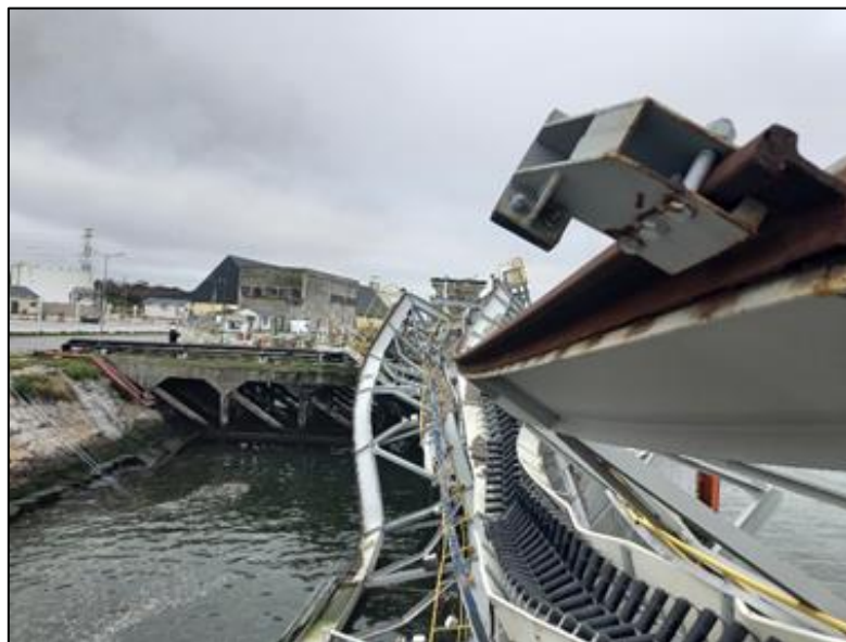
Figura 11. Estructura vista desde duque de alba central. Fuente. JST, septiembre de 2021
