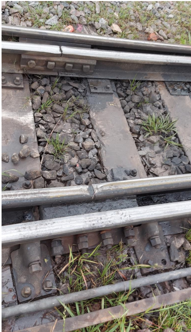
Figura 9. Vista de los indicios del efecto “bombeo” sobre el balasto a la altura del talón de aguja. Fuente: Archivo JST
