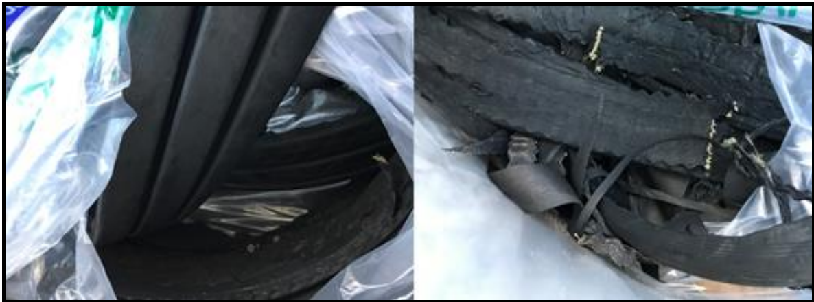
Figura 2. Restos de recapado de la cubierta
